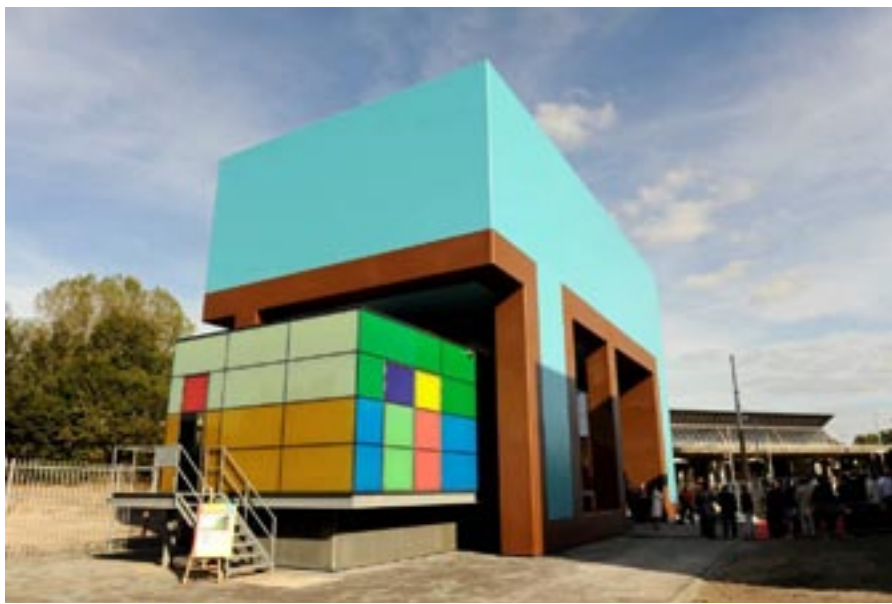
Krijn de Koning, onderstation Amsterdam RAI van ProRail ProRail's Amsterdam RAI substation foto photo: Paul Dijkstra
